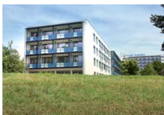
↓ → Nová fasáda s novými moderními a praktickými balkony na pavilonech A i B nejen že Lázním Aurora sluší, ale také ušetří mnoho finančních prostředků za únik tepelné energie.
