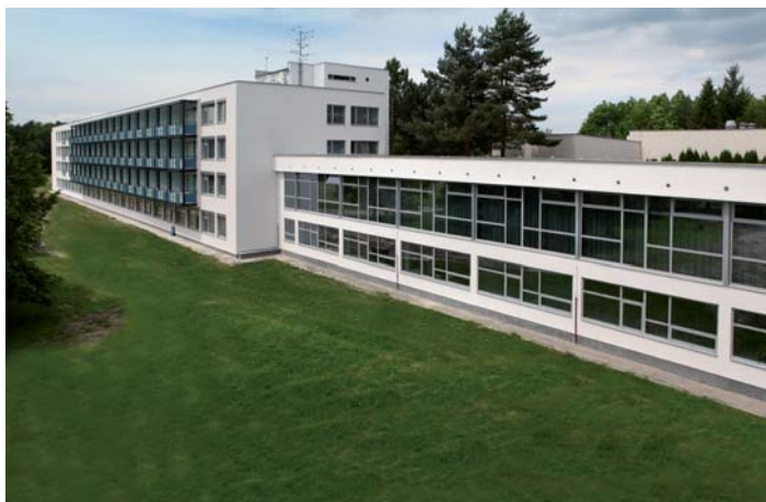
↑ Pohled na zateplené fasády ubytovacího pavilonu B a Zimní zahrady, kde také byla osazena nová vakuová okna.
