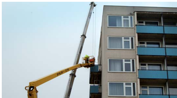
↑ V lednu byly odřezávány vyhlídkové balkóny na jižní stěně budovy A, aby se mohlo začít se stavbou panoramatického výťahu.
