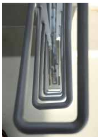
↑ ...a pohled dolů schodištěm.
