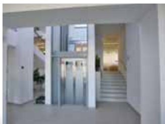
↑ Výtah zprístupňuje bezbariérově příchody do lázní v obou podlažích.
