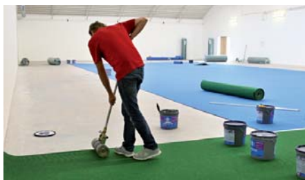
Pokládka tenisového koberce a hotový kurt.
