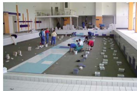
Pokládka dlažby nového bazénu.
