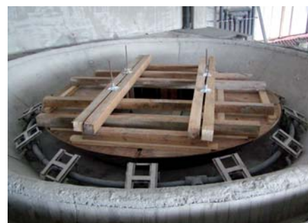
Montáž výstuže a bednění lehátek velkého whirlpoolu.
