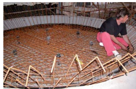
Montáž výstuže a bednění lehátek velkého whirlpoolu.
