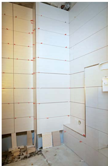
Některé koupelny jsou již obkládány.
