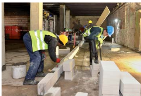
Bývalá a hlavně budoucí kuchyně.
