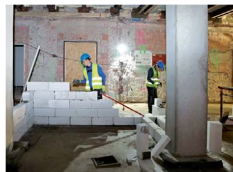
Příčka v budoucí kuchyni.
